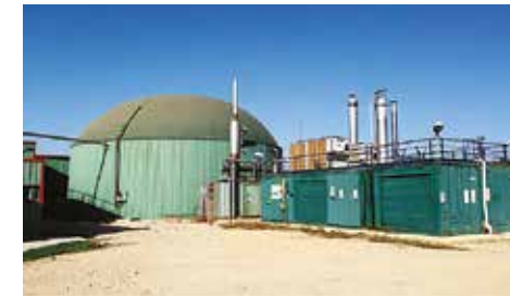
Μονάδα παραγωγής βιοαερίου
